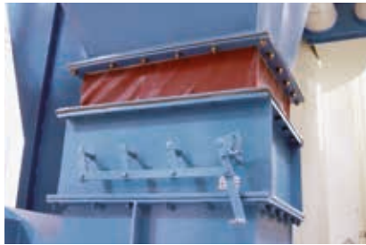
Gewebekompensator mit rechteckigen Flanschen
